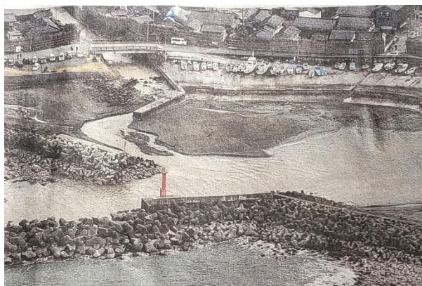
石川県輪島市の大沢漁港。隆起によって海底だった場所(中央)が見えている状態
